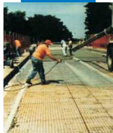
Applying the epoxy primer
